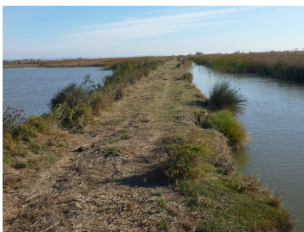
Figure 46. Digue entre le marais du Domaine de Rousty et le réseau hydrographique
