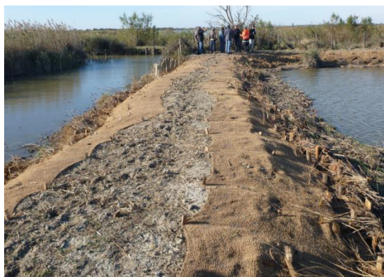
Figure 49. Tronçon de digue réparé et conforté
